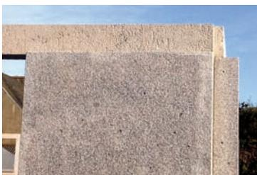
*Détail sur le chaînage béton, sablé pour s'harmoniser avec le granit.*
