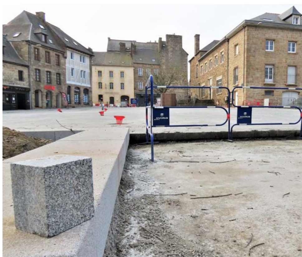
Faute de pavés, le chantier de rénovation de la place de la République est à l'arrêt depuis quelques jours. Fanch LE PIVERT
