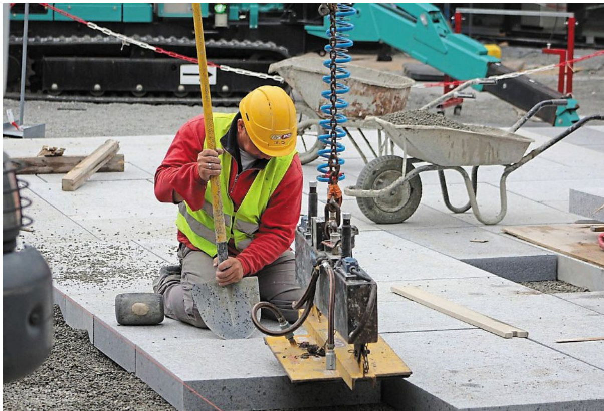
Selon l'association IG Granit de Bretagne, seulement une trentaine des 277 communes bretonnes ont dit oui au granit de Bretagne Ici, la pose d'un dallage en granit de Louvigné-du-Désert (Ille-et-Vilaine).
