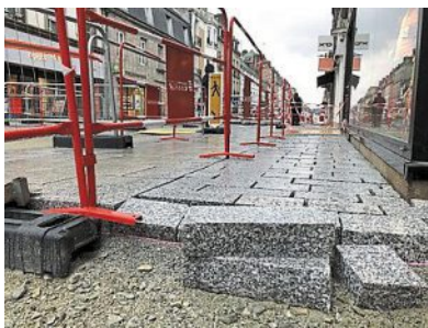
Les premiers pavés ont été posés en septembre, dans la rue Nationale à Pontivy avançant.
