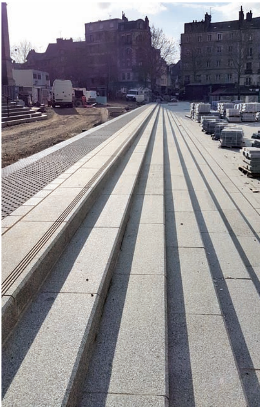
12 000 m 2 de dallage et quelques centaines de mètres linéaires d'emmarchements seront posés Place Sainte-Anne à Rennes, ce qui représente au total 1 500 m 3 de granit extrait des carrières de Louvigné, surtout, et de Lanhélin.
